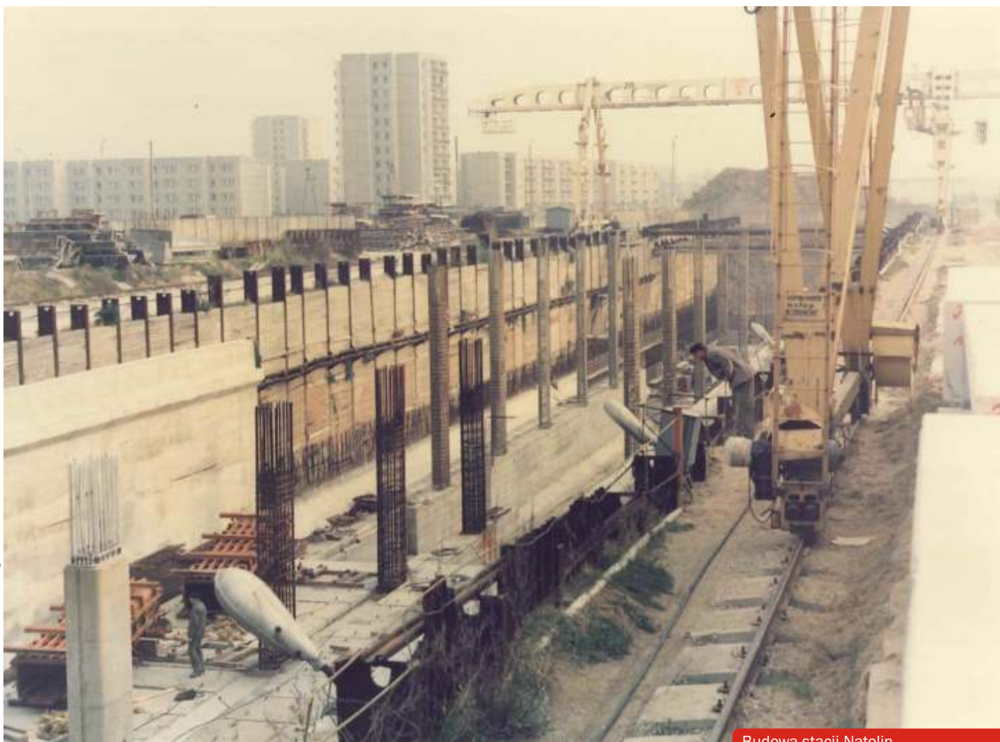
Budowa stacji Natolin
