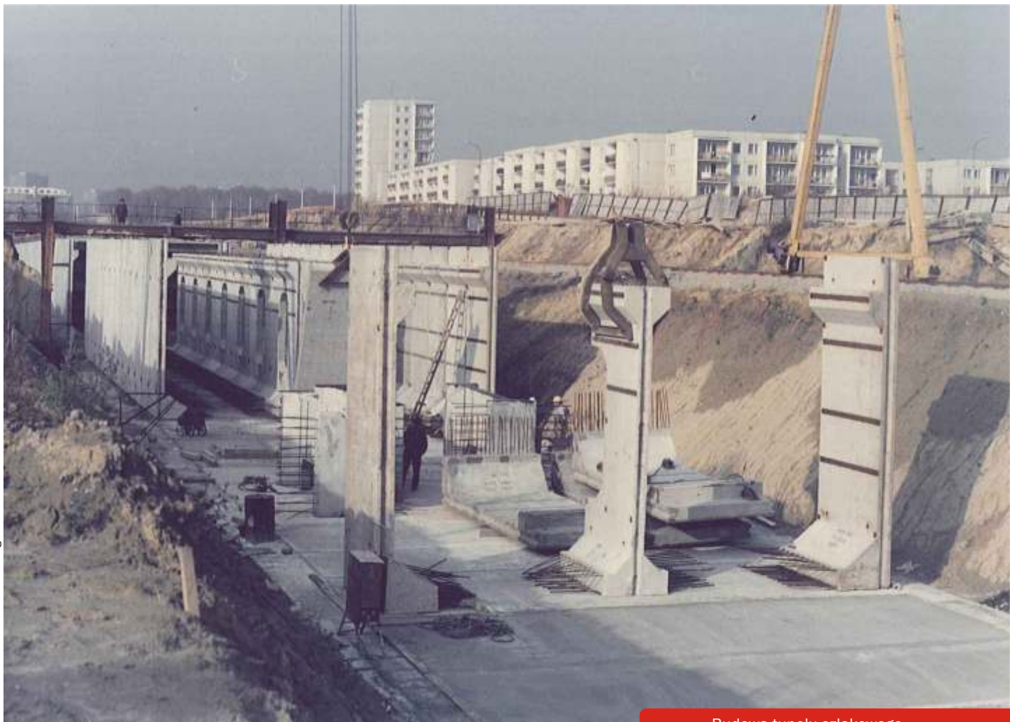
Budowa tunelu szlakowego pomiędzy stacjami Kabaty i Natolin
