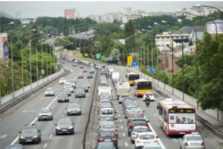
Most Łazienkowski przed pożarem był jedną z popularniejszych przepraw. W godzinach szczytu komunikacyjnego, w ciągu jednej godziny, w kierunku centrum kursowało nim 81 autobusów 12 linii, z których korzystało około 10 tys. pasażerów
