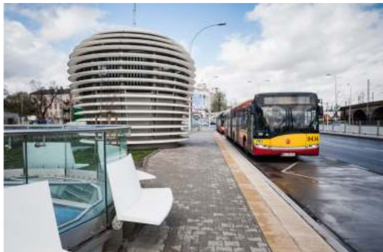
W niespełna miesiąc po wyłączeniu z ruchu mostu Łazienkowskiego uruchomiono II linię metra. Dzięki temu część linii autobusowych można było wycofać z centrum i skierować do stacji metra Stadion Narodowy
