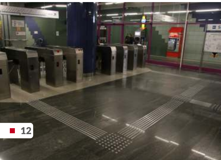
W 2015 r. na 18 z 21 stacji pierwszej linii metra zamontowano ścieżki prowadzące dla osób niewidomych
