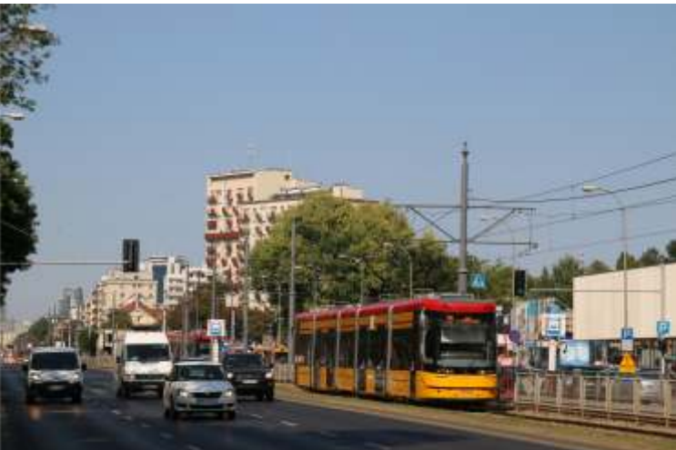
Podczas modernizacji torowiska tramwajowego wzdłuż ulicy Grójeckiej po raz pierwszy wykorzystano nakładkę umożliwiającą tramwajom dwukierunkowym zmianę kierunku jazdy. Specjalna linia tramwajowa 79 obsługiwała trasę P+R Al. Krakowska – Hale Banacha
