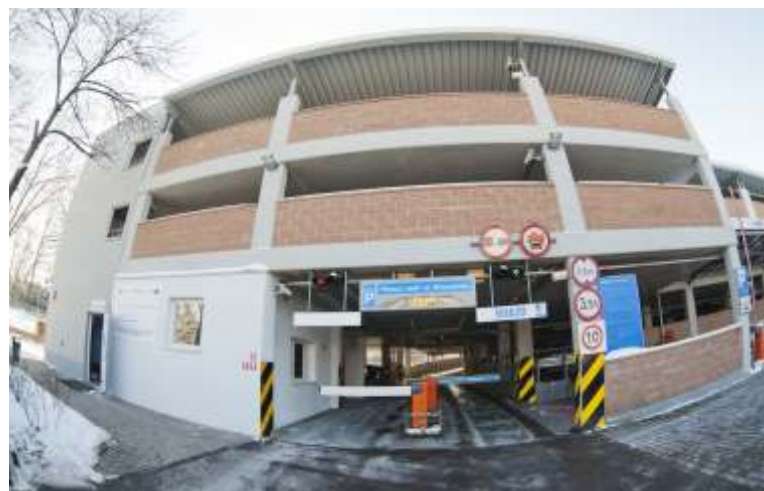
Pierwszy parking „Parkuj i jedź” otwarto w 2007 r. przy stacji metra Marymont. Obecnie funkcjonuje 14 parkingów na ponad 4,2 tys. miejsc
