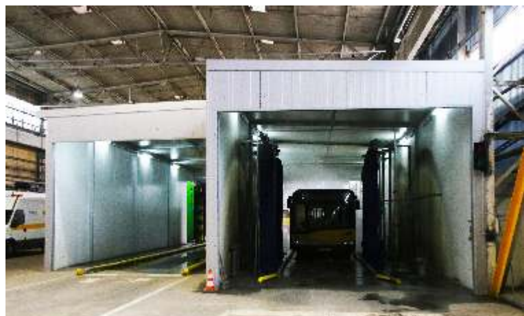
W pełni zautomatyzowana myjnia z zamkniętym obiegiem wody
