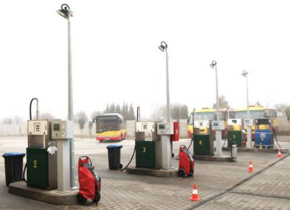
Dystrybutory paliwa na terenie zajezdni. Tankowanie 18-metrowego pojazdu ze zbiornikiem na 300 litrów zajmuje około trzy minuty
